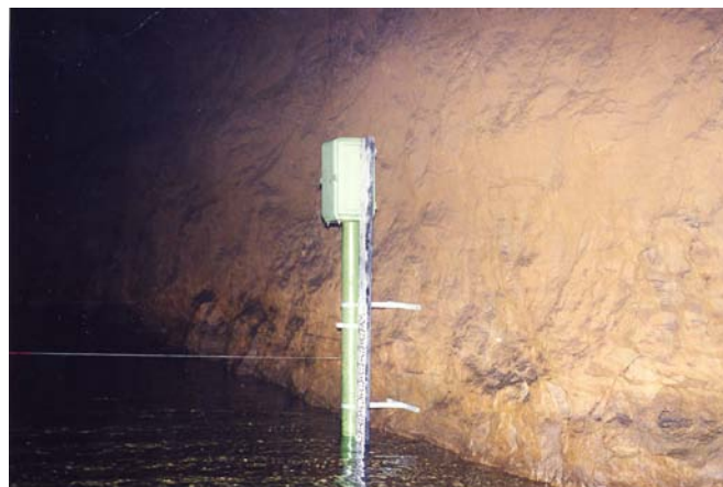
Figure 4.8. : Hydrographe installé sur la galerie drainante de la Mine d'Ottange III (photo : GEREEA).
