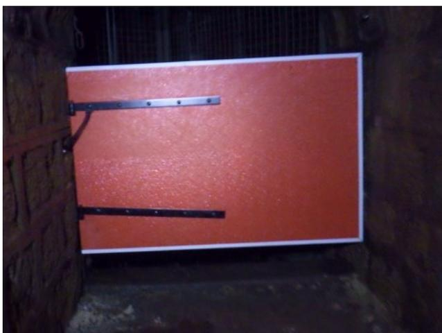
2. Dans le puits Saint-Julien, au niveau du palier situé à la hauteur de la galerie de jonction avec le puits de Clairlieu nous avons posé une trappe qui se referme automatiquement au niveau de l'échelle qui permet l'accès au palier inférieur. Ainsi, si une personne tête en l'air se promène sur le palier, elle ne peut plus tomber par inadvertance dans le trou où passe l'échelle.
