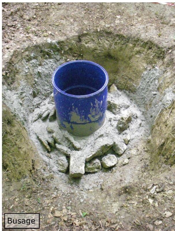
Séance 3 : Les buses, deux fûts (nettoyés !) d'huile de foie de morue pour bétail, superposées ont été posées et scellées avec du béton, des blocs, quelques canettes de
