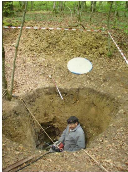
diamètre du **5** remplissage argileux de la doline d'entrée jusqu'à trouver la roche en place pour asseoir le busage. Les choses se sont présentées idéalement grâce à une faille en Y à étayer du côté de l'ouverture.
